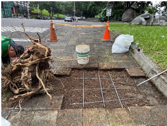
【鋪設鋼條及水泥，穩固地基底層】
