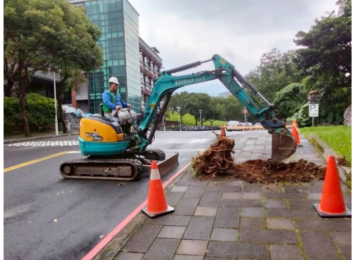
【樹頭枯死影響景觀，以挖土機挖除】
