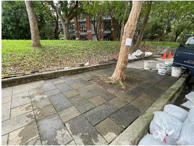
【潑灑適當水量讓底層水泥砂凝固】
