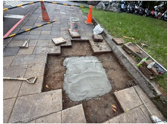
【鋪設鋼條及水泥，穩固地基底層】
