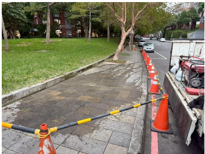
【以乾式水泥工法回填高壓磚，填縫補砂並適度潑水凝固】
