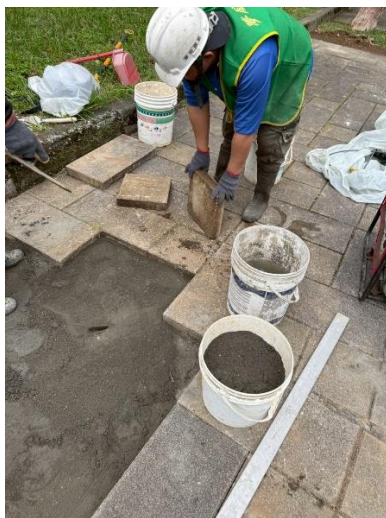
【以乾式水泥工法回填高壓磚，填縫補砂並適度潑水凝固】
