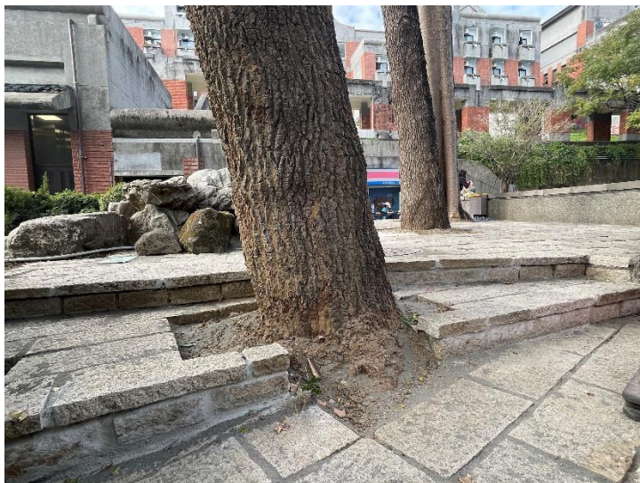
【施工後依根系生長整地】
