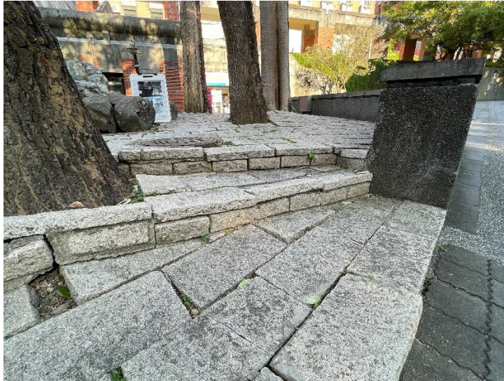
【施工前樹穴完全覆蓋】
